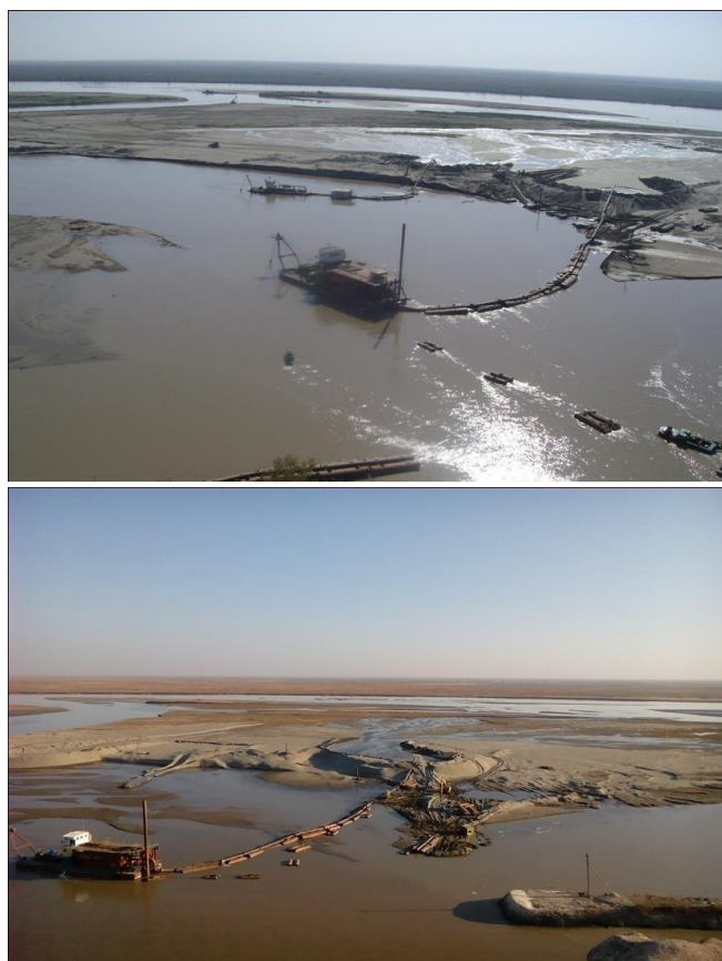
Рис.4. Новые плавучие устройства для изменения структуры потока на водозаборе КМК.
