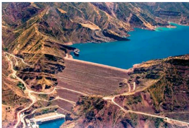
Рис. 1. Плотина Нурекской ГЭС (высота 310м, объём водохранилища 10.5 млрд. куб м.) на реке Вахш – аналог будущей Рогунской плотины
