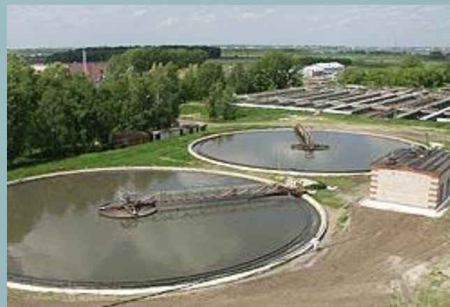
Вертикальный и радиальный отстойники
