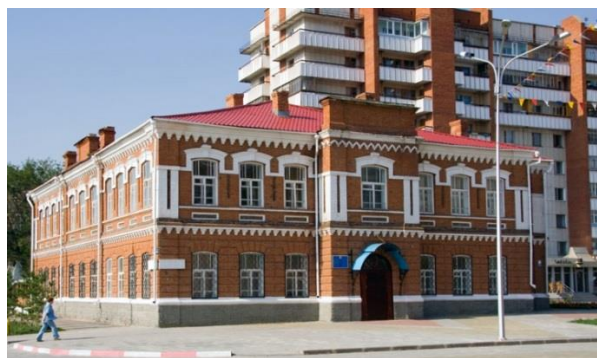
Рисунок 3. Здание мужского 4-х классного училища 1907 год. Современное состояние.
