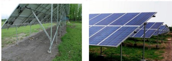
4-rasm. Fotoelement panellarni yer yuzidan imkon darajasida yuqoriga oʻrnatib, uning ostida koʻp yillik oʻsimliklar oʻstirish.
