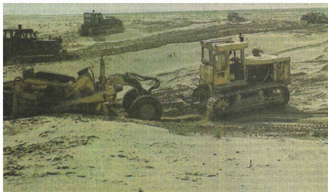
182-rasm. Skrepyerlar yordamida yer tekislash
