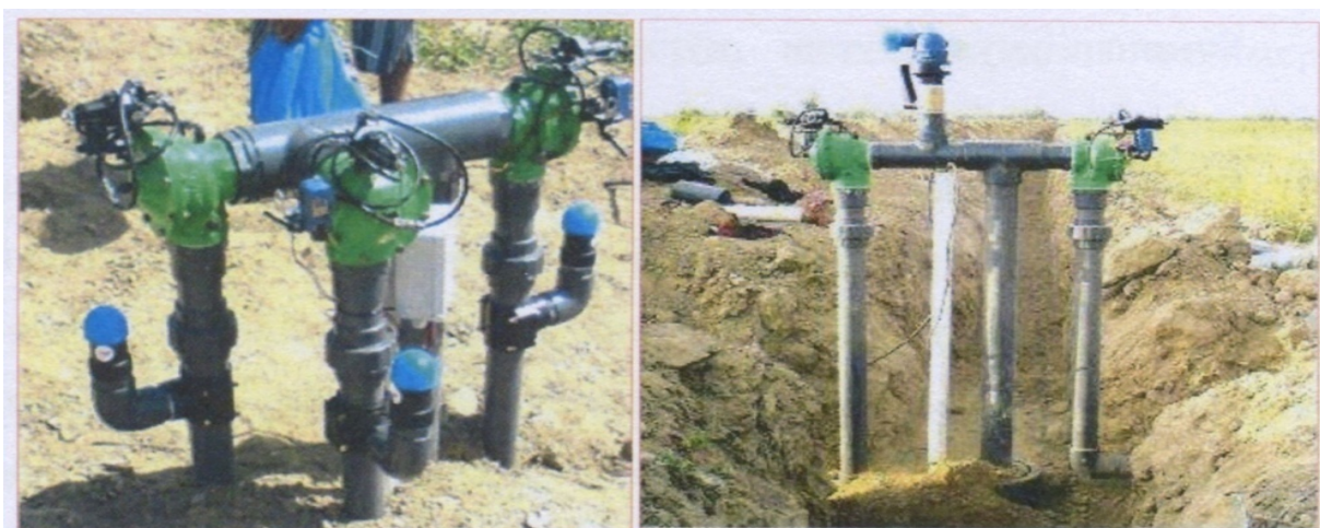
108-rasm. Tomchilatib sug‘orish tizimida ishlatiladigan suv oqimini rostlovchi gidrantlar
