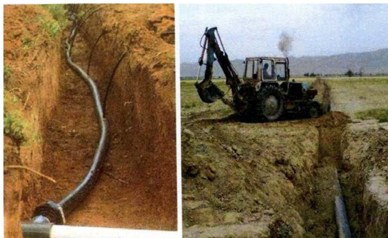
118-rasm. Tomchilatib sug'orish tizimi tarqatuvchi quvurini transheya (ariqlar) ga joylashtirish va ulash
