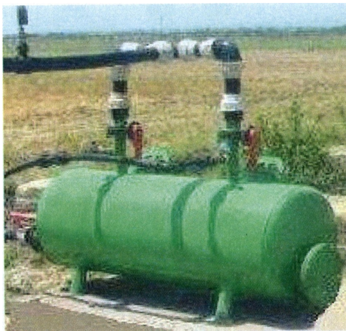
95-rasm. Tomchilatib sug‘orish tizimida ishlatiladigan ikki kamerali qumli filtrning umumiy ko‘rinishi
