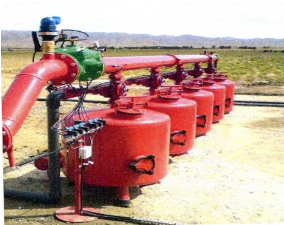
94-rasm. Tomchilatib sug‘orish tizimida ishlatiladigan bir kamyerali qumli filtr
