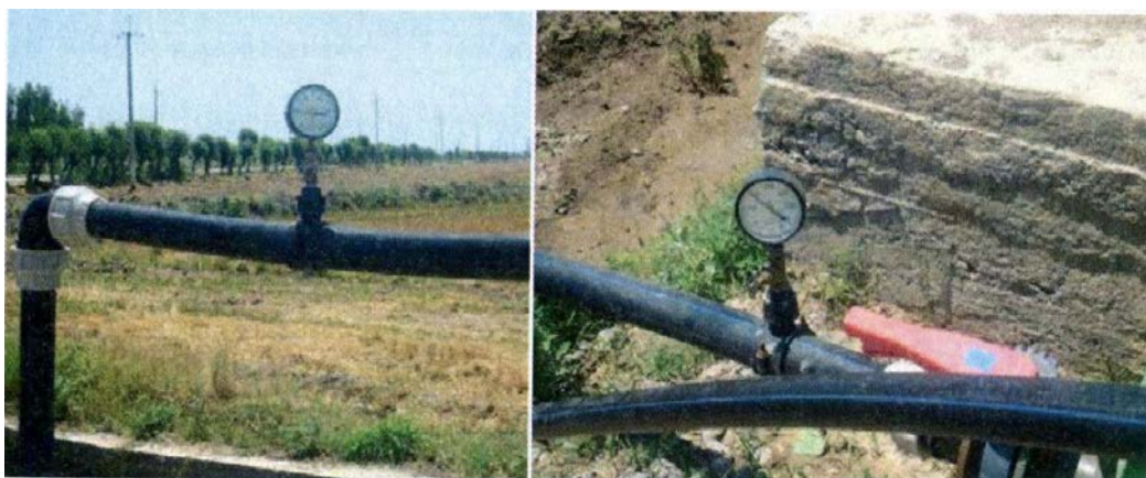
107-rasm. Tomchilatib sug‘orish tizimining bosimni nazorat qiluvchi manometrlari
