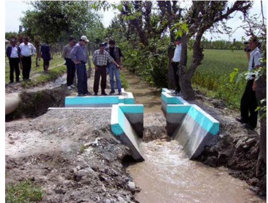
189-rasm. Suv o‘lchash gidropostlari
