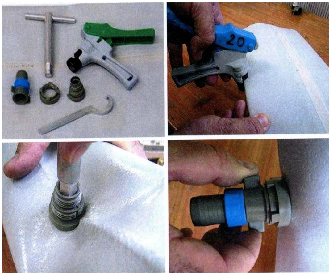
117-rasm. Tomchilatib sug'orish tizimining tarqatuvchi quvuriga shtutsyerlarni o'rnatish
