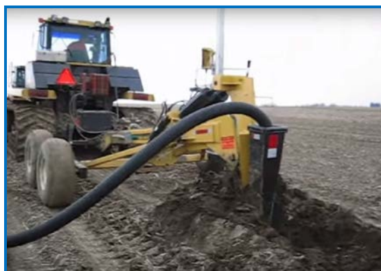
75-rasm. Namiqtiruvchi quvurlarni o‘rnatish
