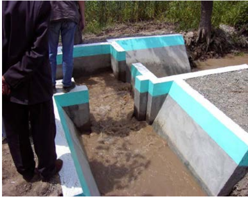
189-rasm. Suv o‘lchash gidropostlari
