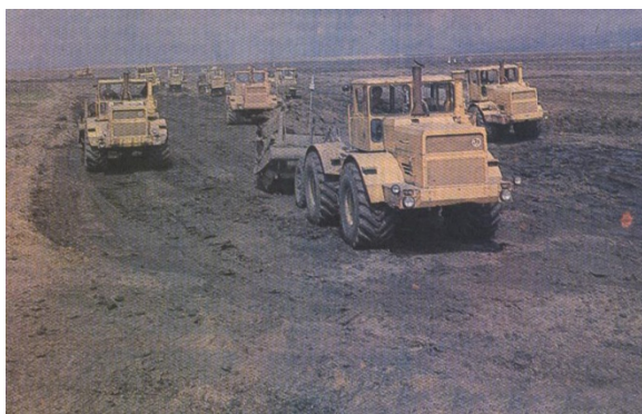
182-rasm. Skrepyerlar yordamida yer tekislash
