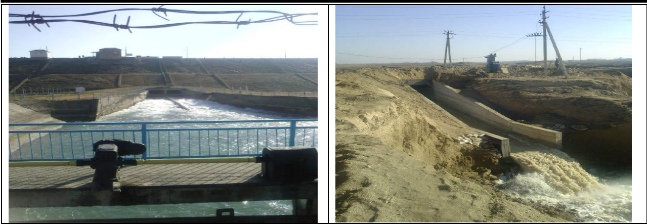
Рис.2 Узел-вододелитель с боковым водовыпуском
