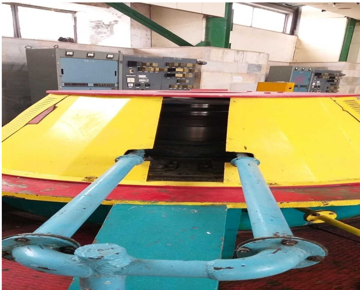
7.15 –rasm. Sovutish tizimiga suv berish quvurlari.
