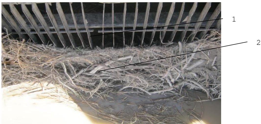
4.15-rasm – Panjaralar oldida to‘planib qolgan oqiziq.
