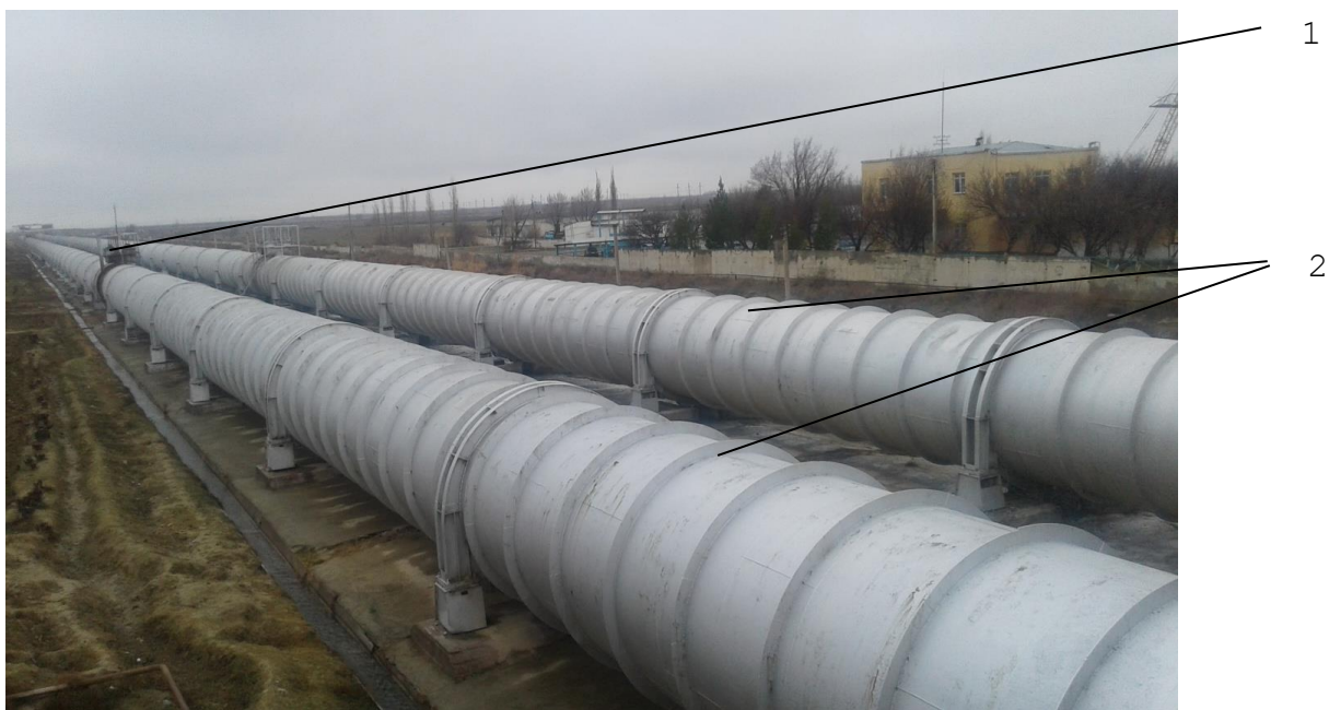
6.5.-rasm. Jizzax bosh nasos stansiyasi bosimli quvurlari.
