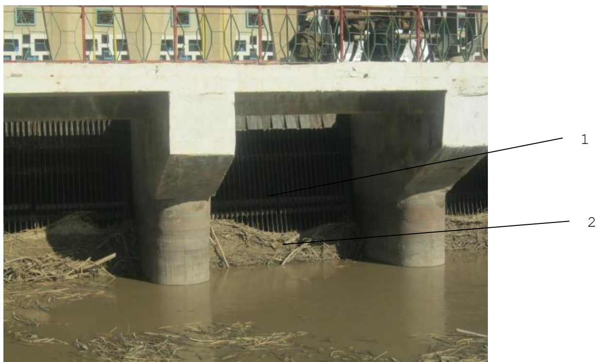
4.16-rasm Amu-Buxoro-2 nasos stansiyasida o‘rnatilgan panjaralar oldida oqiziqning to‘planib qolishi.
