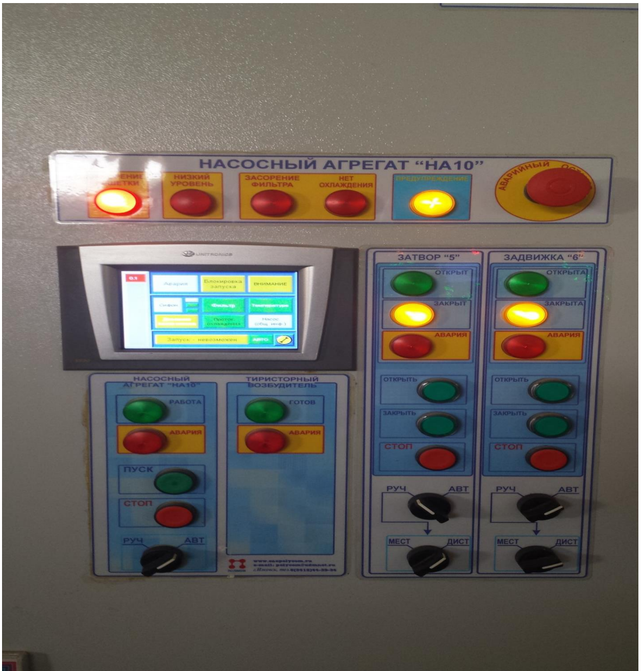
7.17-rasm.Nasos qurilmalarini nazorat qilish va boshqarish tizimi.
