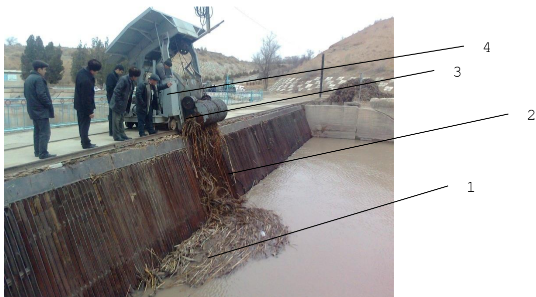
4.14-rasm. Amu-Buxoro-1 nasos stansiyasida panjara oldida to‘plangan oqiziqnlarni olib tashlash jarayoni
