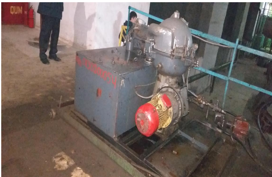
7.12-rasm. Jizzax nasos stansiyalarida moy tozalash tizimi.
