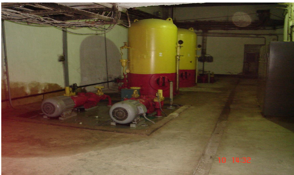
7.16-rasm. Avariya holatlarida zatvorlarni ochish va yopishni ta'minlash tizimi.
