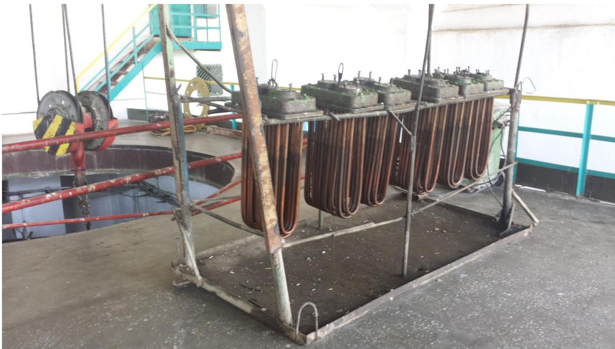
7.14 –rasm. Elektrodvigatel moy sovutgichlari.
