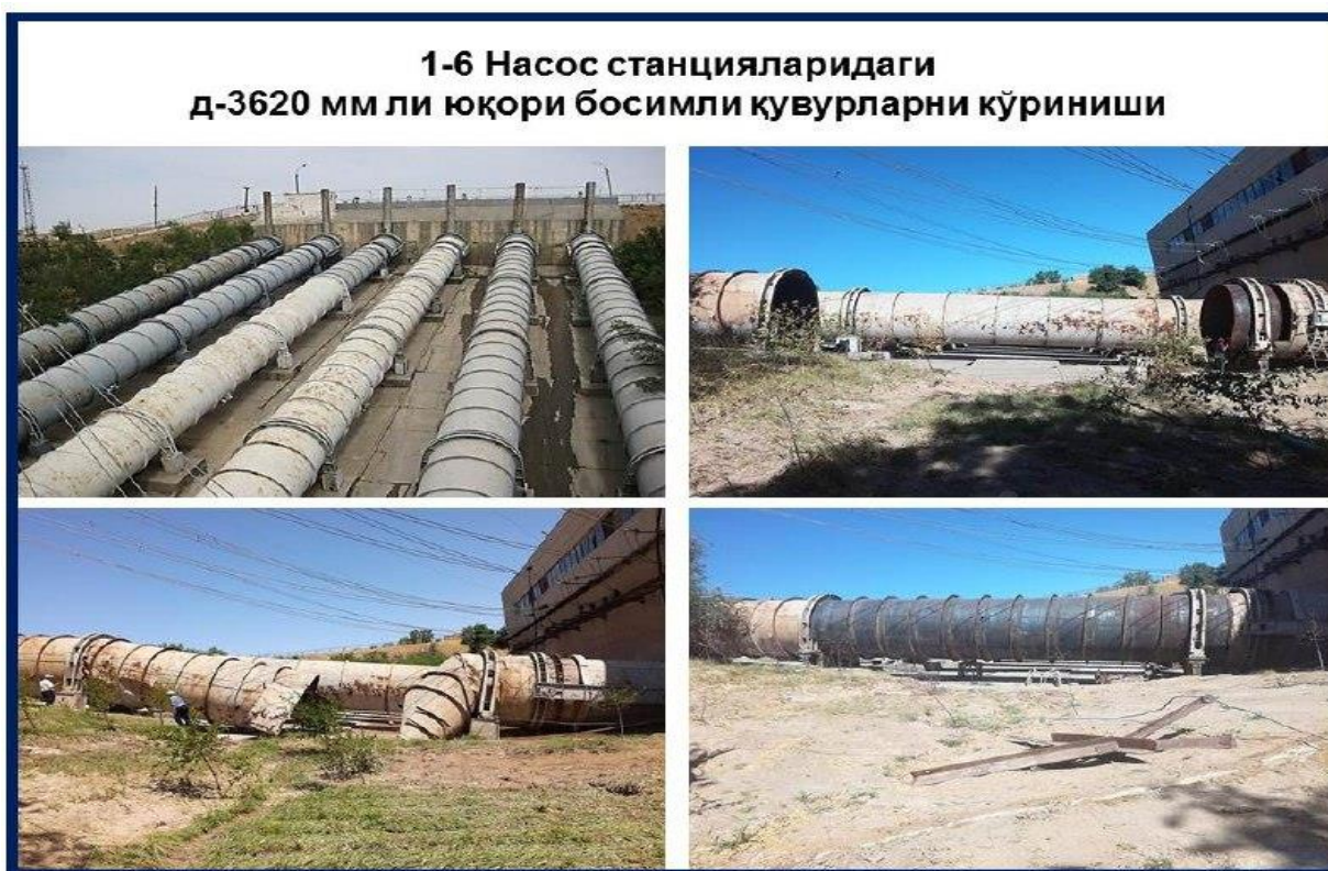
6.7–rasm. Bosimli quvurlarining yorilib ishdan chiqishi va uni almashtirilib ta‘milangan holati.
