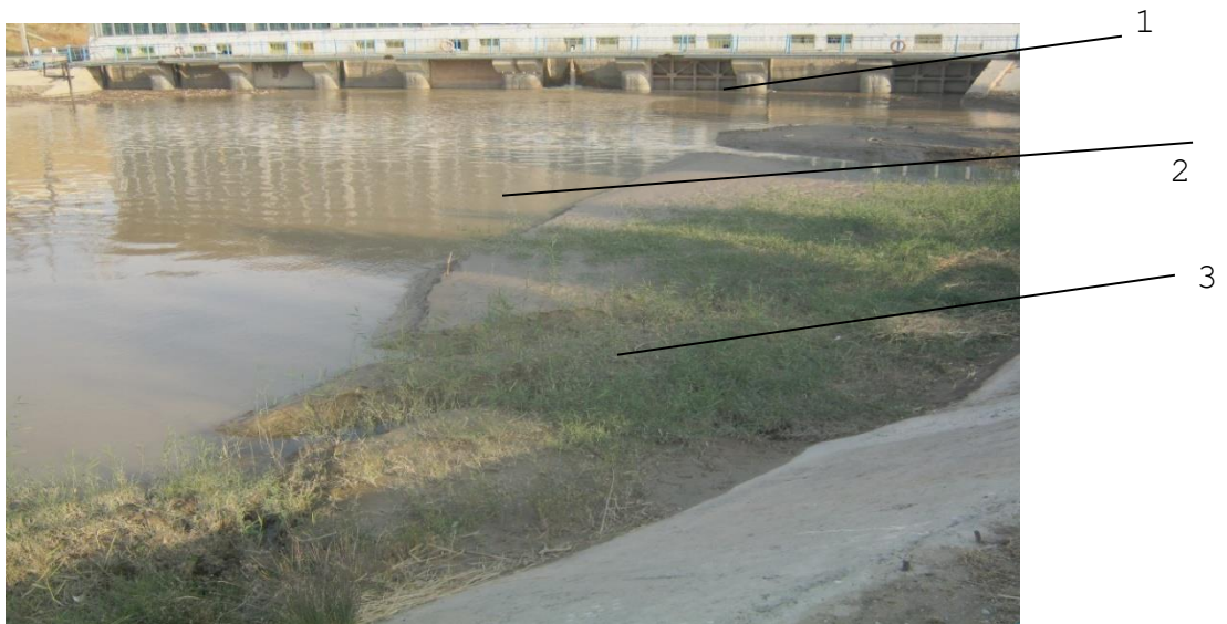
3.16-rasm. Amu-Buxoro -1 nasos stansiyasi avankamerasida loyqaning to‘lib qolishi.
