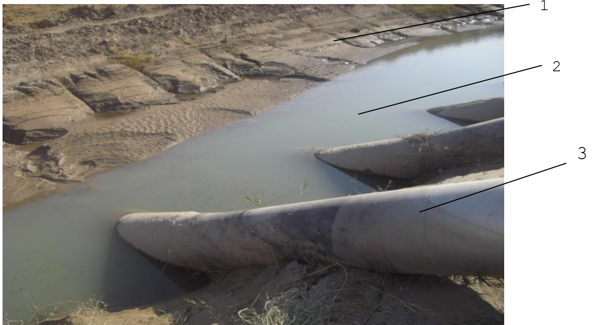
3.15-rasm. Qorovulbozor nasos stansiyasida suv keluvchi kanalga loyqa to‘lib qolgan holati.
