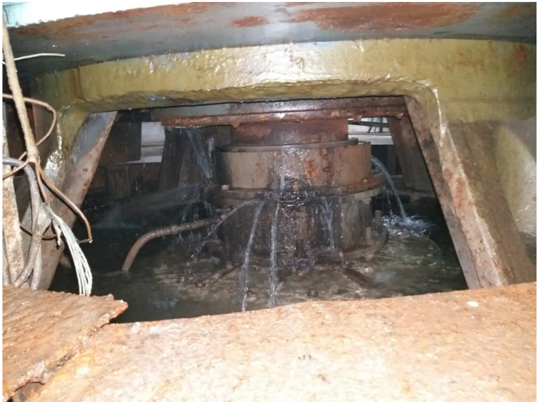
7.4-rasm. Nasos agregatini suv bilan sovutish tizimi.
