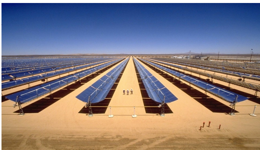
Рис.1. Солнечные параболоцилиндрические концентраторы для получения электрической энергии
