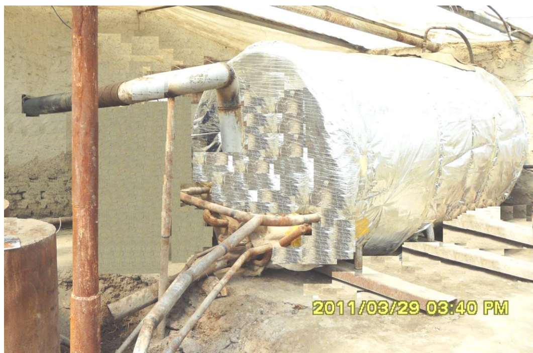
Рис.2.30. Биогазовая установка с полезным объемом 5 м 3 , установленная в Гиждуванском районе Бухарской области
