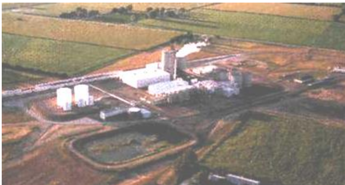
Рис. 3.4. Завод по производству этанола
