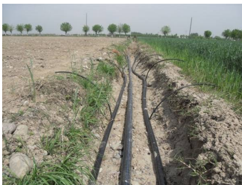
Система в процессе установки на поле
