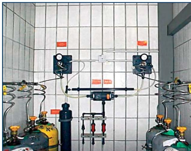
Рис. 2.11-б. Система с линией коллектора
