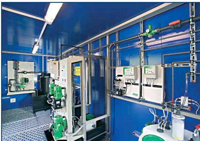
Система Oxiperm 166 с подготовительным резервуаром для раствора  $\text{NaClO}_2$
