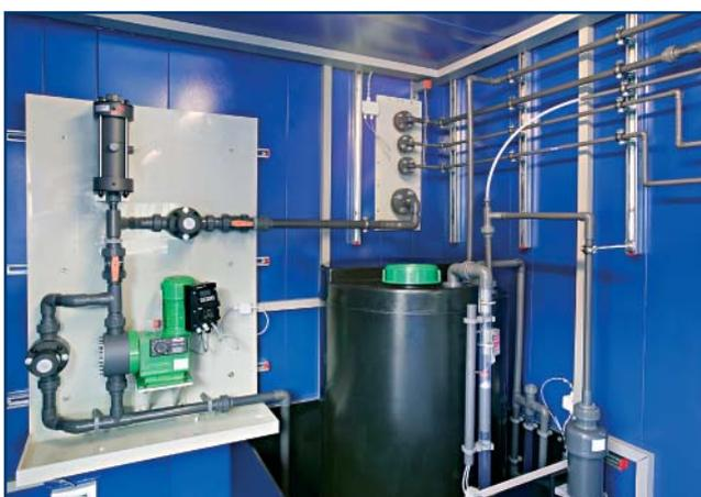
Станция дозирования раствора  $\text{ClO}_2$  с измерительным модулем типа Conex
