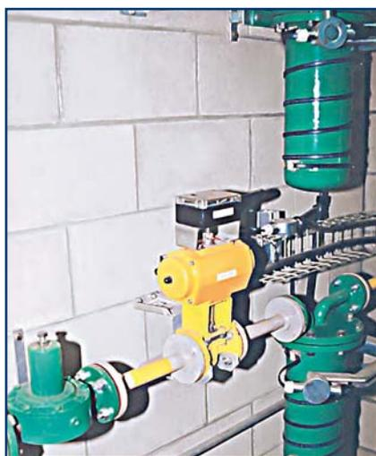
Рис. 3.4. Редукционный клапан 544
