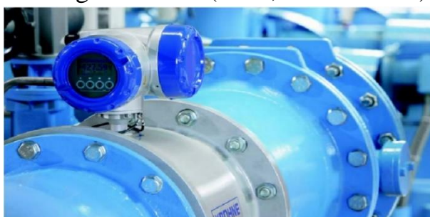
5.50.-rasm. KROHNE (Germaniya) firmasining elektromagnitli sarf o'lchagichlarining quvurda joylashtirilishi
