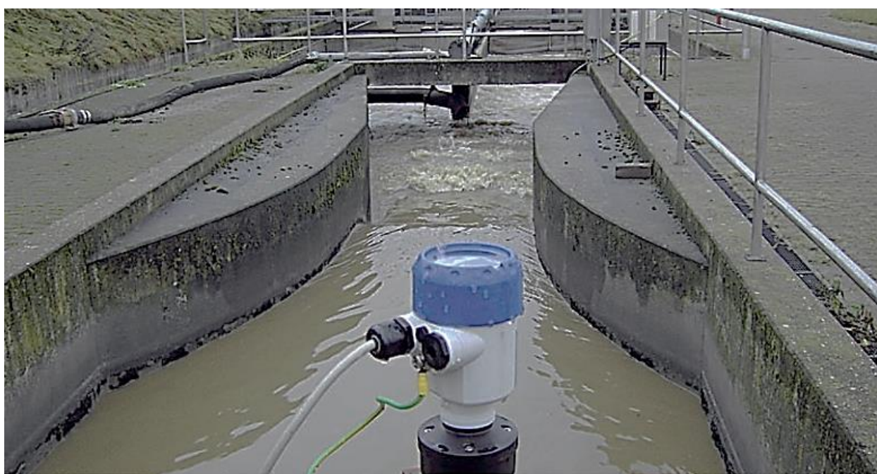
5.16- rasm .Suyuqliklar va sochiluvchan moddalar uchun OPTISOUND-inovatsiyon ultratovushli yechim
