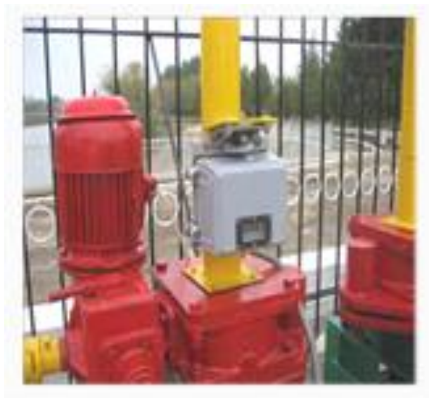
5.7- rasm. EIM ning mexanizmlarining joylashtirilish sxemasi
