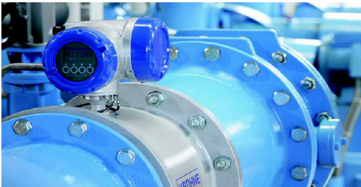
4.11-rasm. KROHNE (Germaniya) firmasining elektromagnitli sarf o'lchagichlarining quvurda joylashtirilishi
