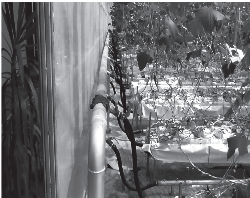
10.4-rasm. Issiqxonani avtomatik isitish va sug'orish tizimlari.
