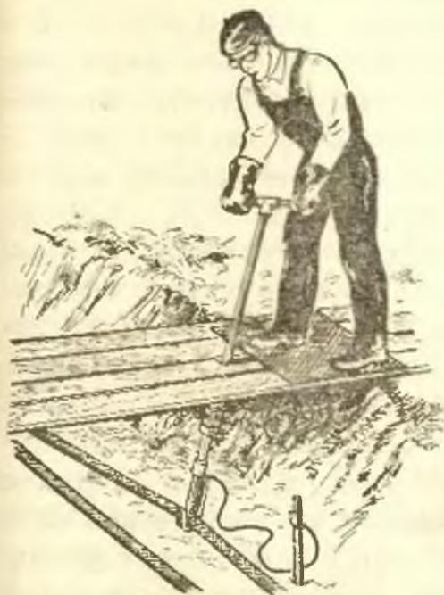
Рис. 67. Прокол кабеля специальным приспособлением
