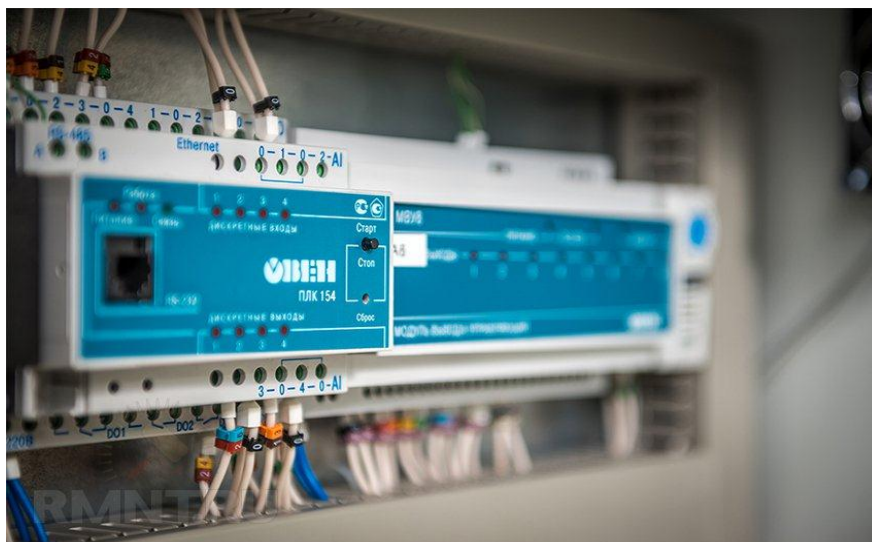
3-расм. DIN-рейкада «ОВЕН» контроллери
