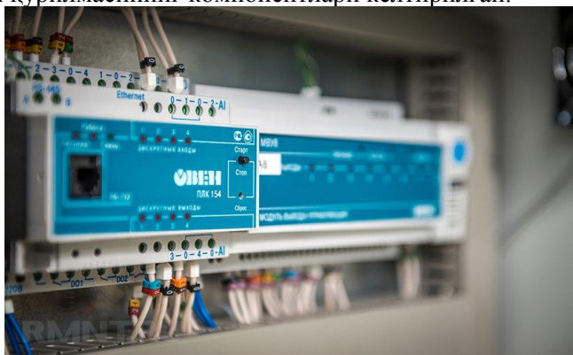
2-расм. DIN-рейкада «ОВЕН» контроллери
