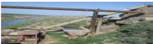
1-расм. Тажриба участкасида ўрнатилган насос. Зовур сувларидан суғоришда фойдаланиш
