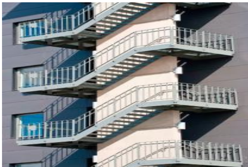
5.3 – rasm. Ko'p qavatli binoning tashqi yong'in qochish yo'lagii 25 .
