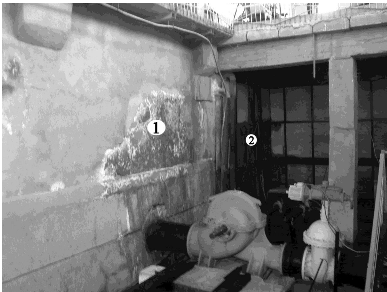
3.1- rasm. Nasos stansiyasi ichida devor sirtida hosil bo‘lgan g‘uborlanish (1) va oqish dog‘i (2).
