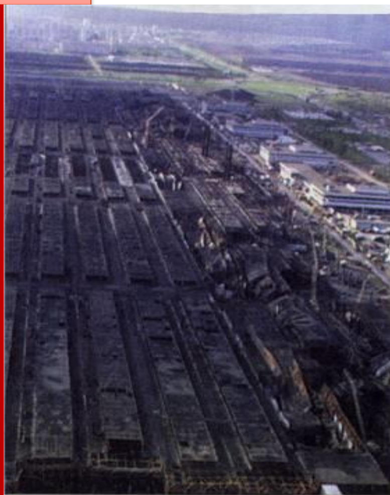
Последствия пожара на заводе двигателей АО «КамАЗ»
