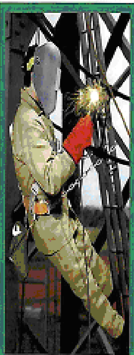
ОДЕЖДА СВАРЩИКА ОБЕСПЕЧИВАЕТ ЗАЩИТУ ОТ ПРОДУКТОВ ГОРЕНИЯ
