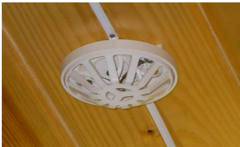
Рис.19 Тепловой извещатель
