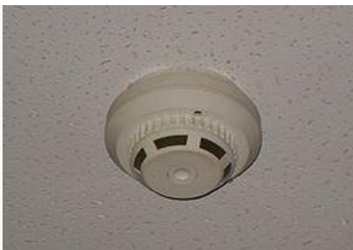
Рис. 20 Точечный дымовой извещатель
