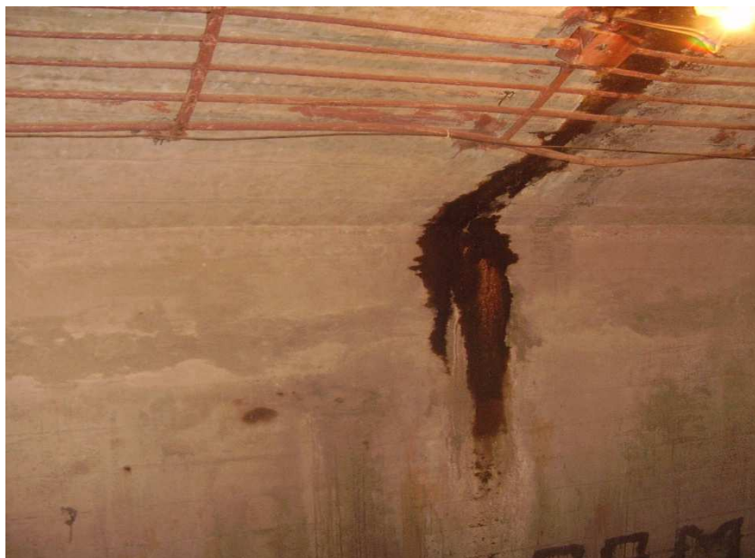
1-расм. Сув чиқариш галереяси шифтидан филтрация сувларининг сизиб чиқиши.
