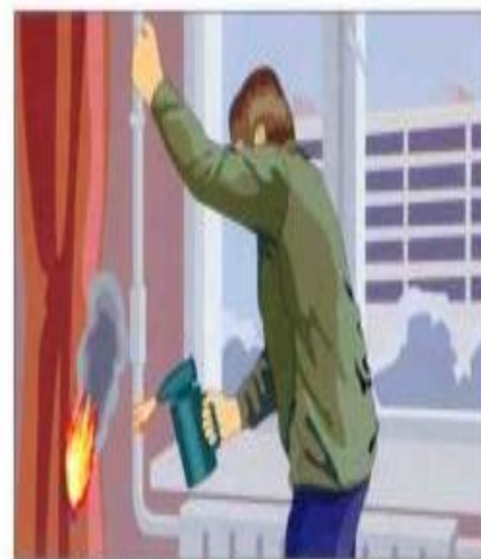
Отогревание замёрзших труб пальцами лампы и факелами
