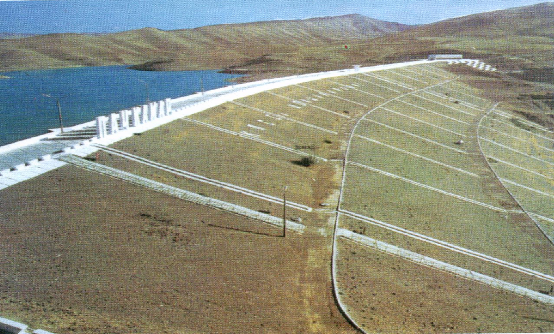
Плотина Пачкамарского гидроузла на реке Гузардарья, Узбекистан высота плотины – 71 м; объем водохранилища – 260 млн.м 3
