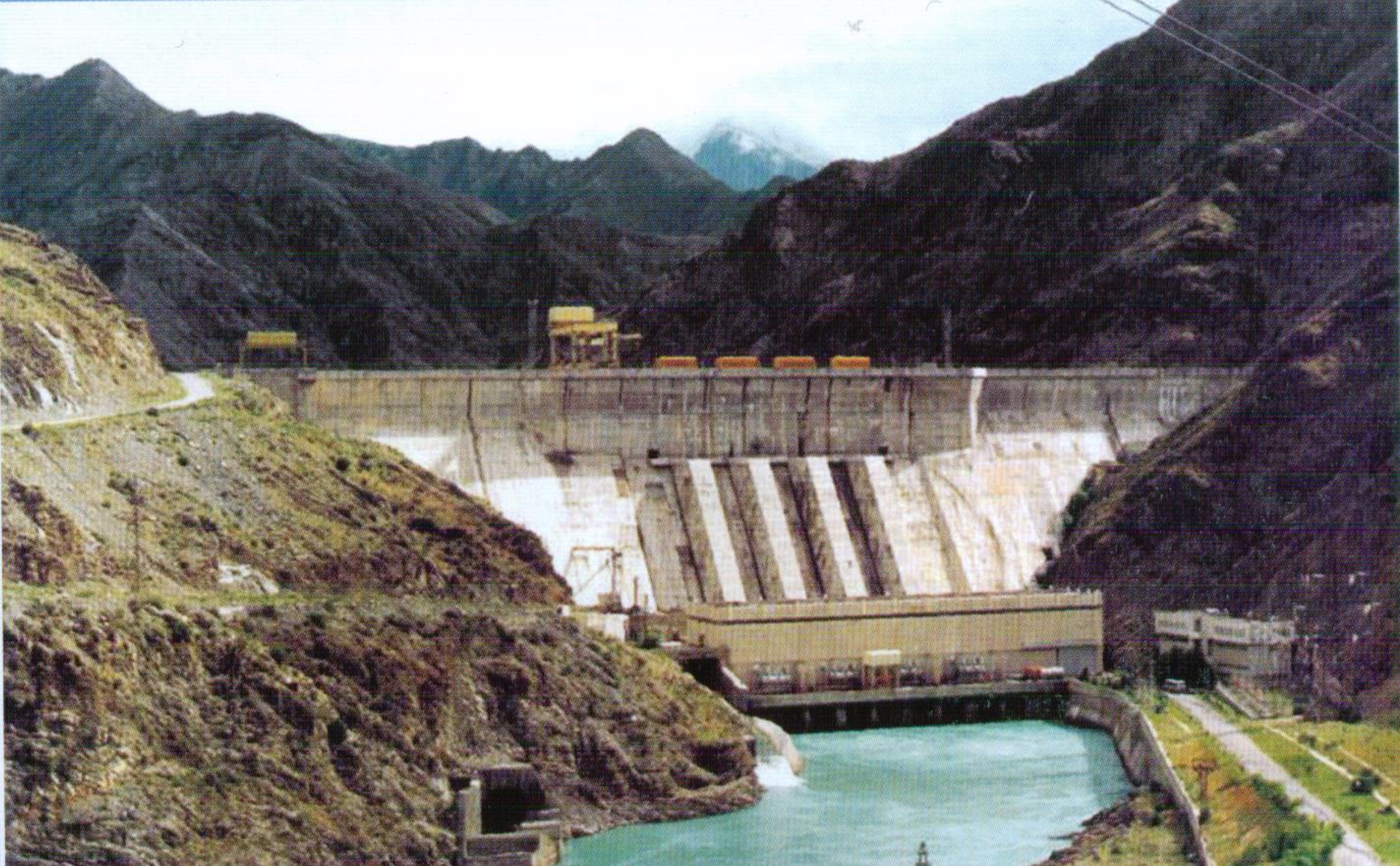
Плотина Курпсайского гидроузла на реке Нарын, Кыргызстан высота плотины – 113 м; объем водохранилища – 370 млн.м 3
