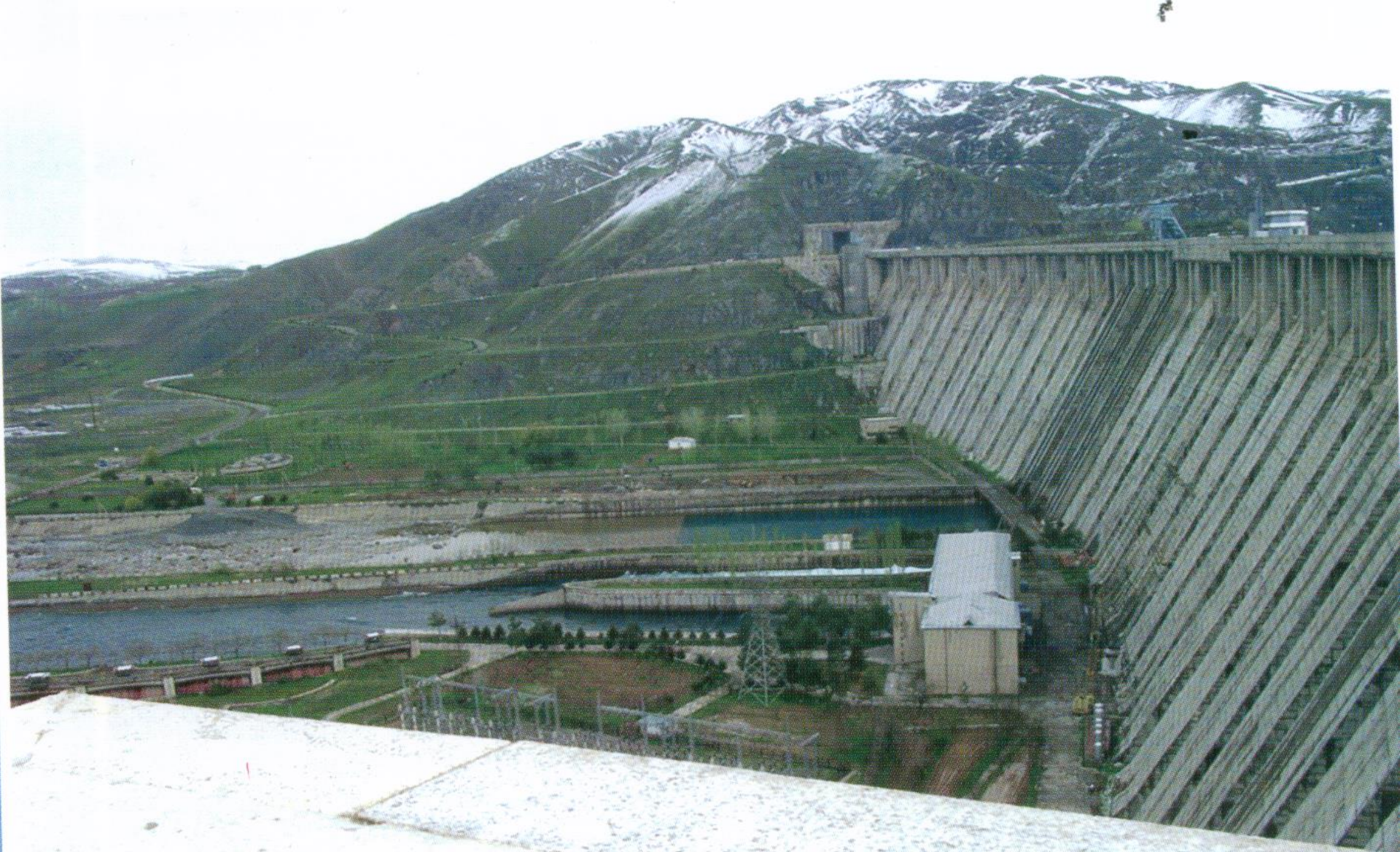
Плотина Андижанского гидроузла на реке Карадарья, Узбекистан высота плотины – 121 м; объем водохранилища – 1900 млн.м 3
