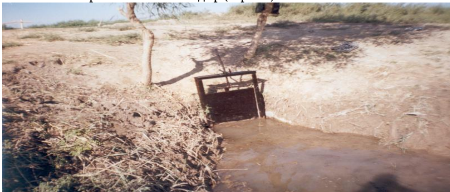
1-расм. Бирламчи зовур охиридаги сув тўсувчи иншоот.
