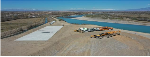
3-rasm. Hidroelektr stansiyasi kaskadi qurilish ob'yekti
