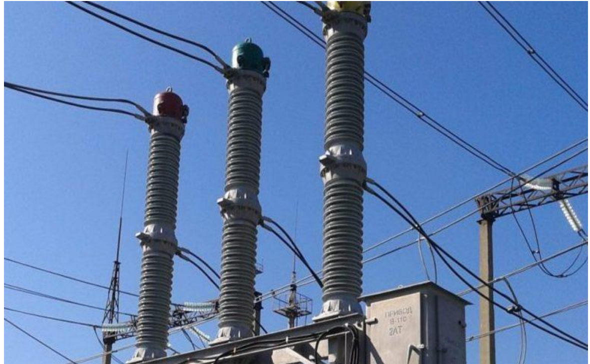
Выключатель маломасляный трехполюсный ВМТ-110
