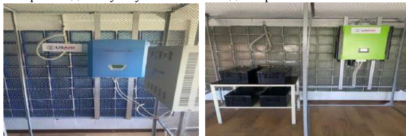
Рис. 3. Контроллер заряда, аккумуляторы и инвертор от солнечной электрической станции
