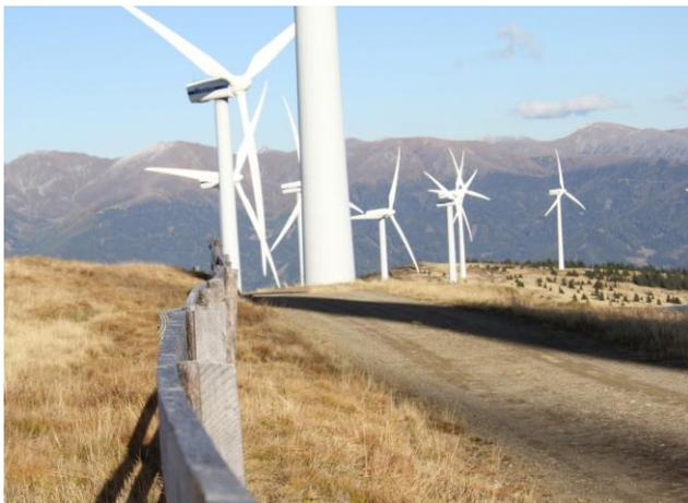
Для расчета устанавливаемой мощности ветровой энергии использована промышленно-стандартная ветровая турбина с высотой ступицы **100м**, диаметром ротора **100м** и генератором мощностью **3 МВт**.
