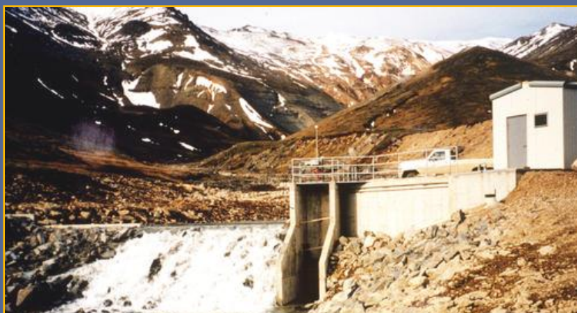
Система с малой ГЭС на 800 кВт, г. Кинг Коув, 700 человек жителей
