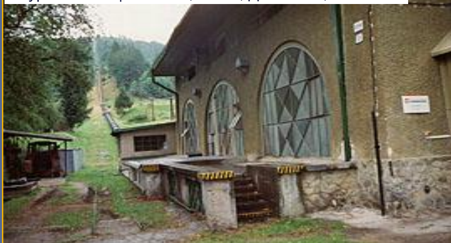
2 турбины мощностью 2,3-МВт, Джейсени, Словакия
