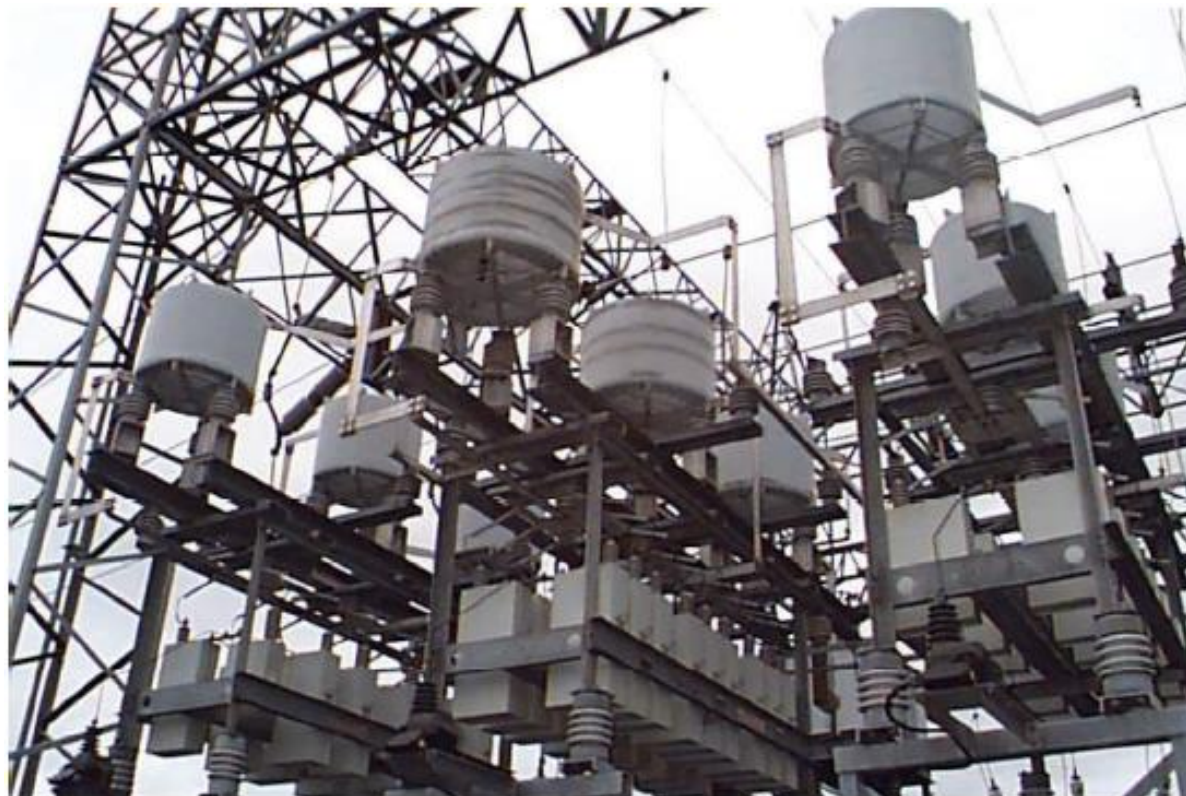
Пример фильтра гармоник на 13.8 кВ
