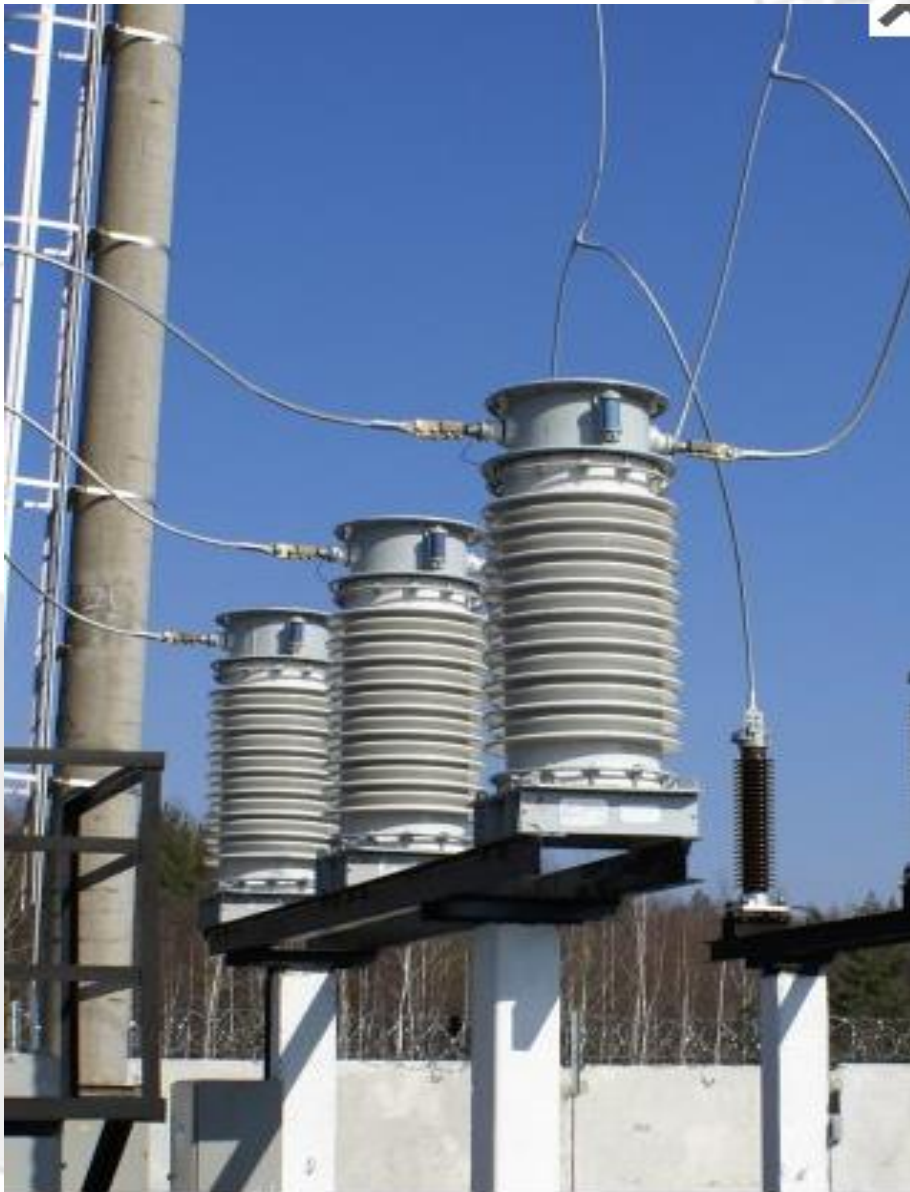
Трансформаторы тока на напряжение 110 кВ серии ТФМ, ПС Дворики, Серпухов
