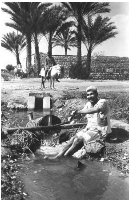
(d) Archimedian screw pump in Egypt
