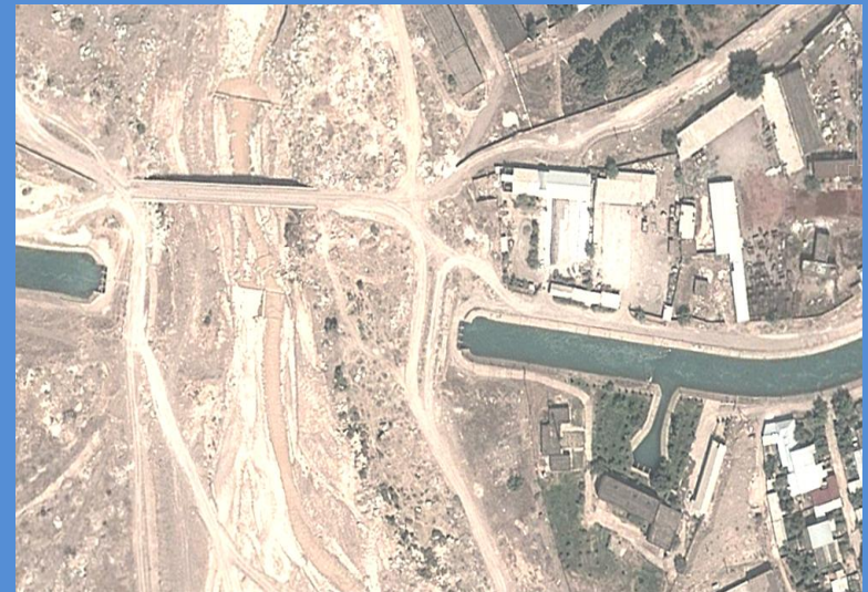
Оқсоқотасой дюкери ва насос станцияси (ПК12)
