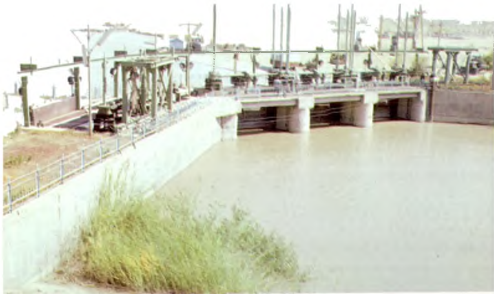
Гидроузел на Аму-Бухарском канале
