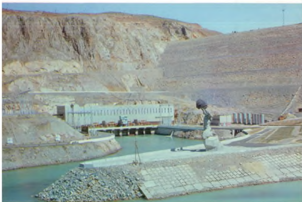
Чарвакская ГЭС. Общий вид отводящего канала
