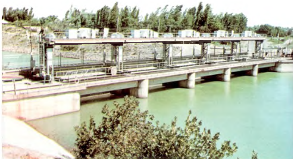
Головное сооружение канала им. Кирова в Сырдарьинской области
