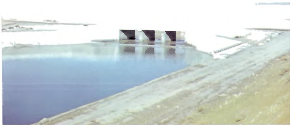
Гидроузел на Аму-Бухарском канале
