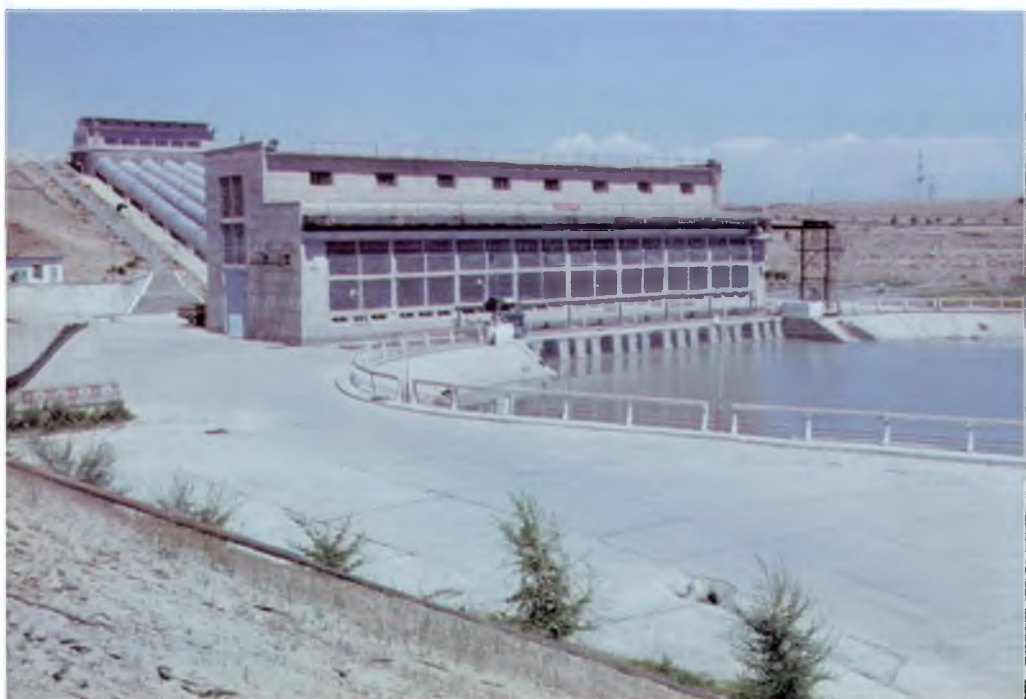
Насосная станция на Каршинском канале
