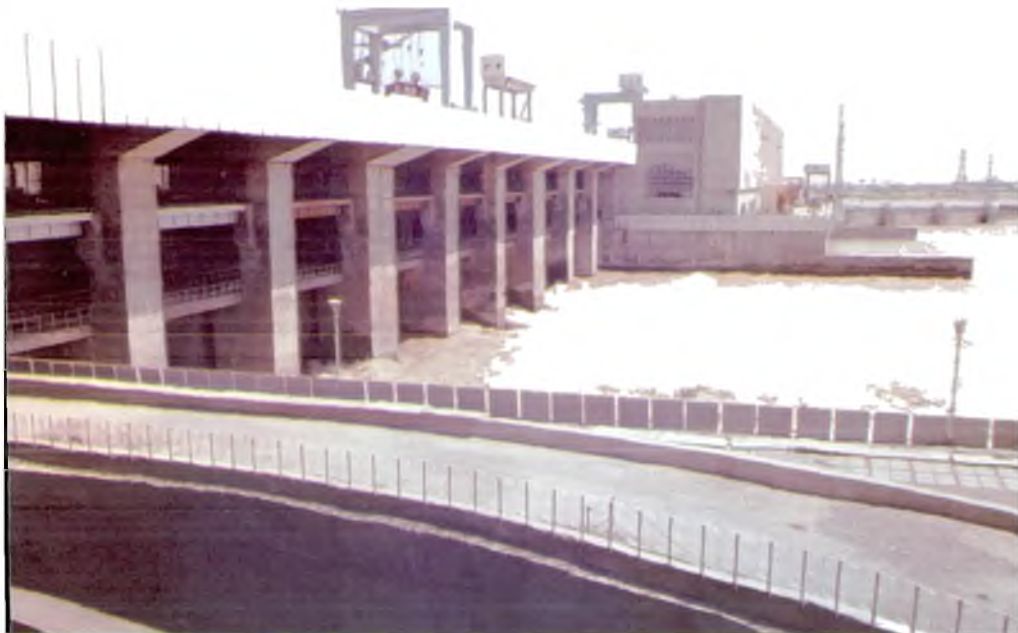
Туямунский гидроузел на Амударье
