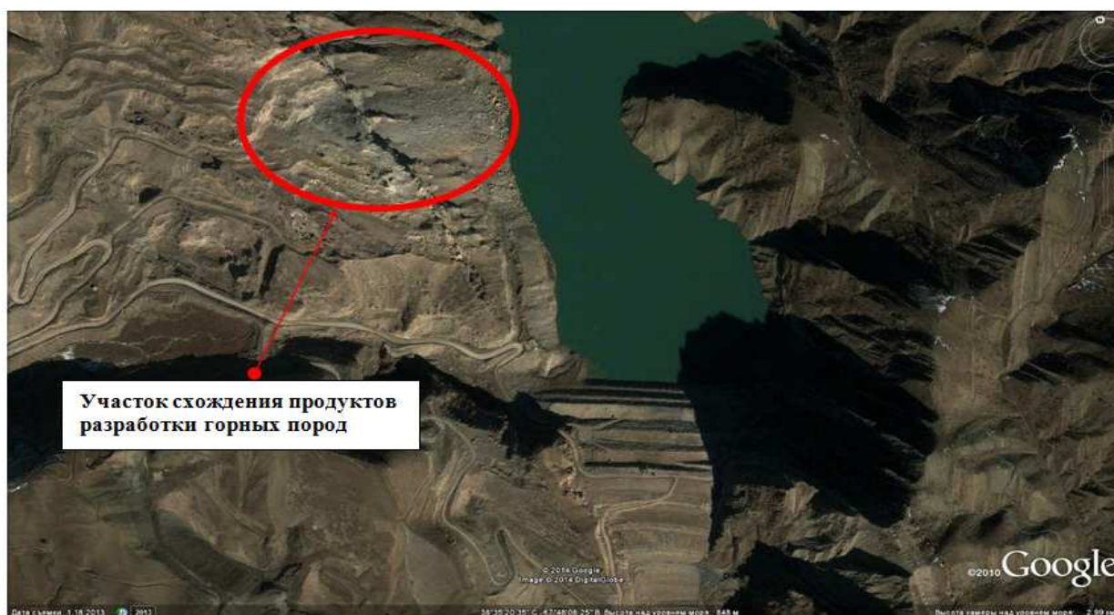
Рисунок 2. Вид со спутника верхнего бьефа Туполангского гидроузла
