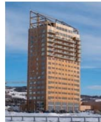
4-расм. Баландлиги 85,4 метрли, кўп қаватли «MJORSTARNET» ёғоч конструкцияли биносининг умумий кўриниши, Норвегия.
