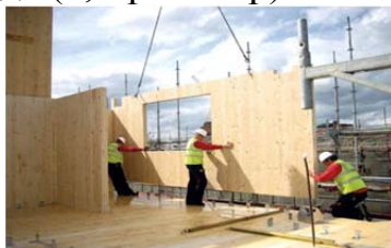
1-расм. Ёғоч конструкцияли «CLT» - панелларини йиғиш жараёни.
