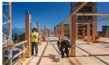
2-расм. 18 қаватли ёғоч конструкцияли бино элементларини йиғиш жараёни, Ванкувер шаҳри, Канада.
