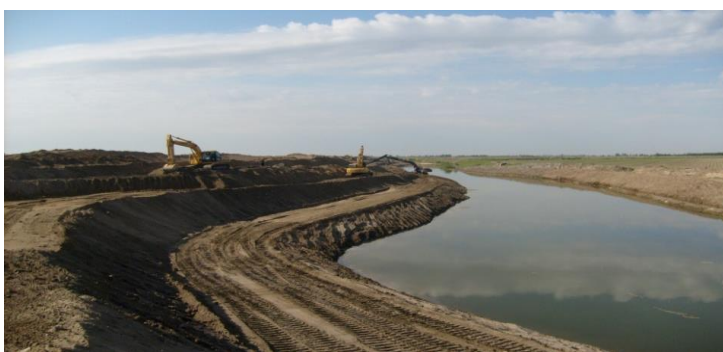
1-rasm. Zovurlarni tozalash va rekanstruksiya jarayoni.
