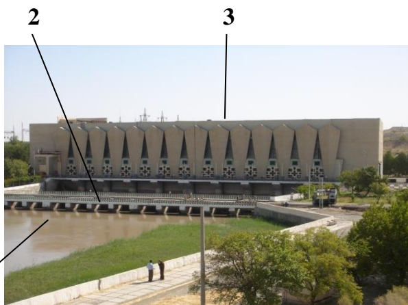
1-Расм. Аму-Бухоро-2 (Хамза-2) насос станцияси биносининг кўриниши. 1- аванкамера, 2- ифлосликларни ушлаб қолиш кўприги, 3-насос станция биноси;
