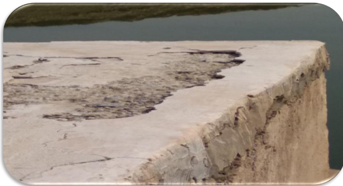
2-расм. ПК 74+5 Юқори қияда жойлашган бетон қопламаларни ҳолати
