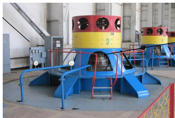
2-Расм. 82В-17 марказдан қочма сув насоси электродвигатели 1- ток уйғотиш қурилмаси, 2 - юқори қисм подшипниги
