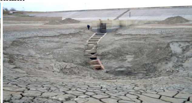
4-расм. Дехқонобод сув омбори сув чиқариш иншооти каллагига зонаси лойқаланиши кўриниши
