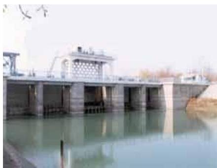
Главное гидротехническое сооружение Туран-хисока
