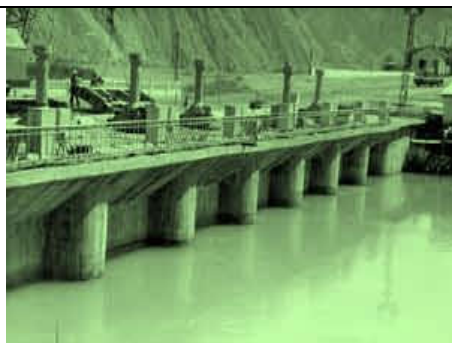
Магистральный канал Вахш 7
