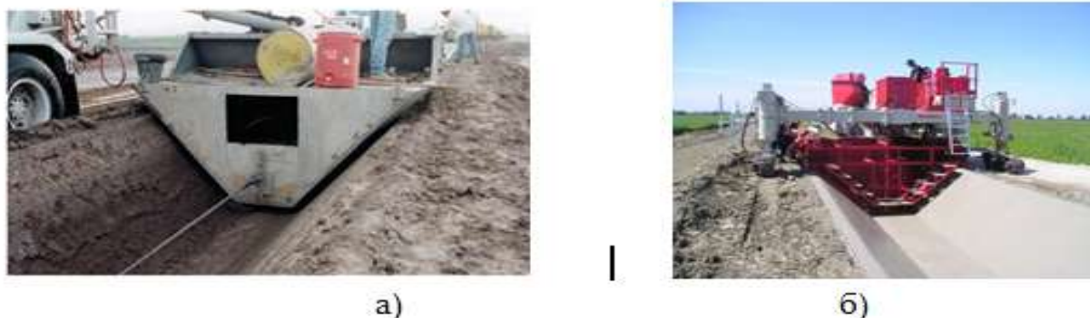
Рис. 293. Бетонирования канала виброформой: а) буксирная виброформа, б) самоходная вброформа
