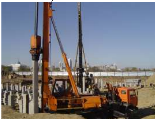
Рис. 189. Копровая установка на автомобильном ходу УГМК-12 в процессе забивки свай
