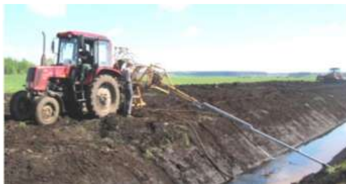
Рис. 314. Установка для промывки дренажа УПД-120
