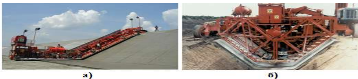
Рис. 294. Самоходные бетоноукладчики: а) полупрофильный, б) полный профильный
