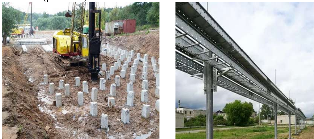
Рис. 179. Установка свайных опор
