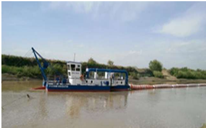
Рис. 169. Очистка реки земснарядом
