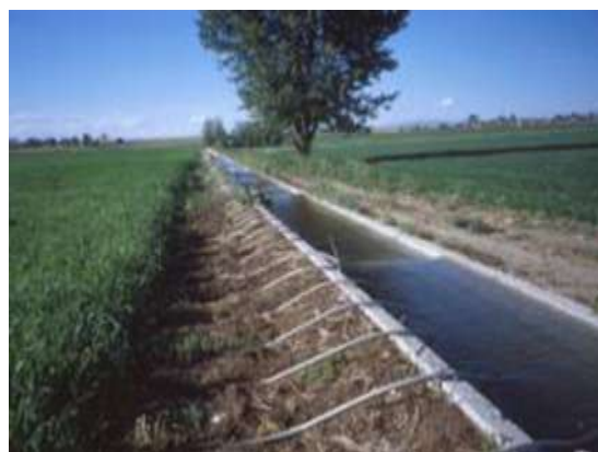
Рис. 334. Забор воды из лотковых сетей с помощью групповых сифонов
