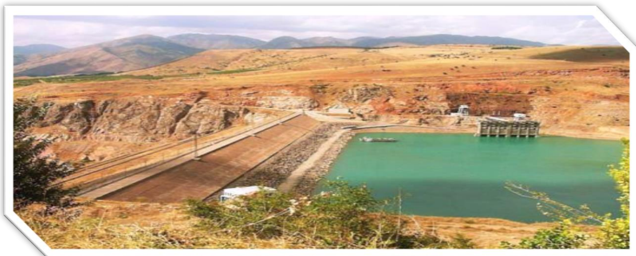
3.12-rasm. Tunelli suv chiqarish va suv tashlash inshooti.
