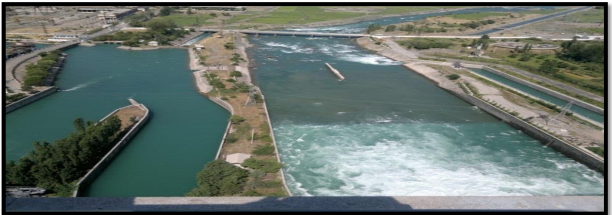
3.14-rasm. Suv omboridagi yordamchi inshootlar : qirg‘oq himoyalovchi inshootlar, muzdan himoyalovchi qurilmalar, ta‘mirlash zatvorlari, xizmat ko‘priklari va boshqalar (11-b. Spravochnik GS).
