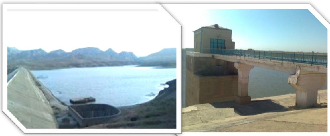
3.13-rasm. Shaxtali suv tashlash inshootlari.
