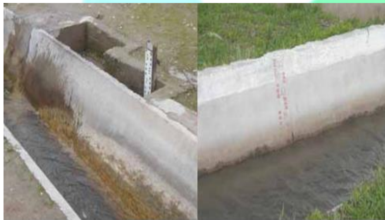
Рис. 8. Градуированный параболический лоток а) с успокоительным колодцем б) с расходомерной шкалой
