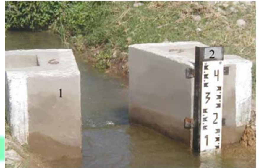
Рис. 3. Водомерный лоток САНИИРИ, подводная часть 1 - входные открылки, 2- гидротехническая рейка
