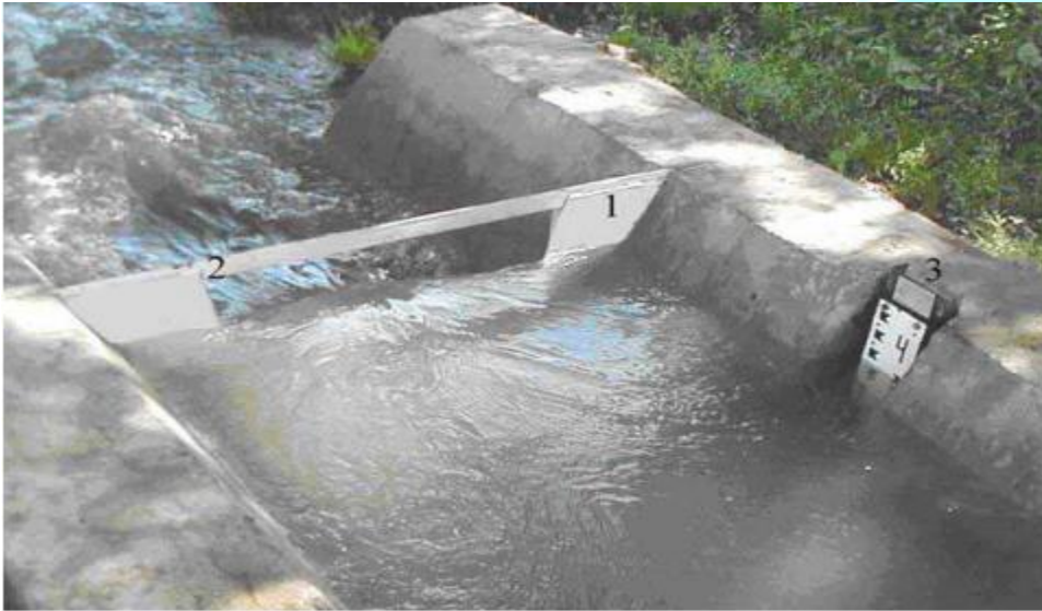
Рис. 4. Трапецидальный водослив
