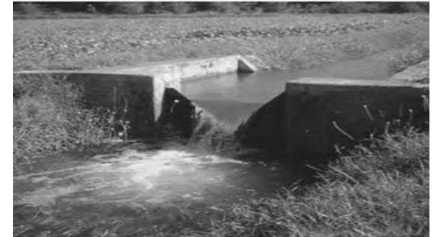
Водослив треугольной формы
