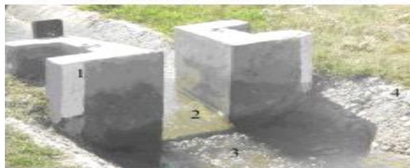
Рис.3. Водомерный лоток САНИПИР, подводящая часть. 1 - входные откраски, 2 - гидротехническая рейка.
