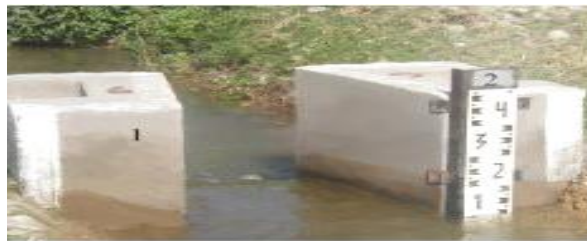
Рис.3. Водомерный лоток САНИПИР, подводящая часть. 1 - входные откраски, 2 - гидротехническая рейка.
