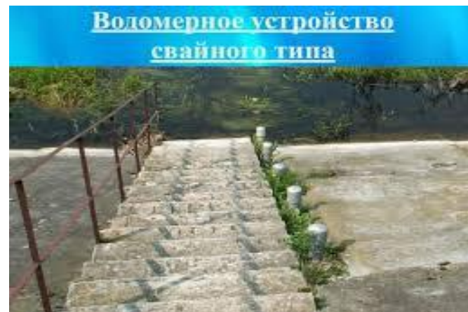
Рис. 9. Схема свайного водомерного поста
