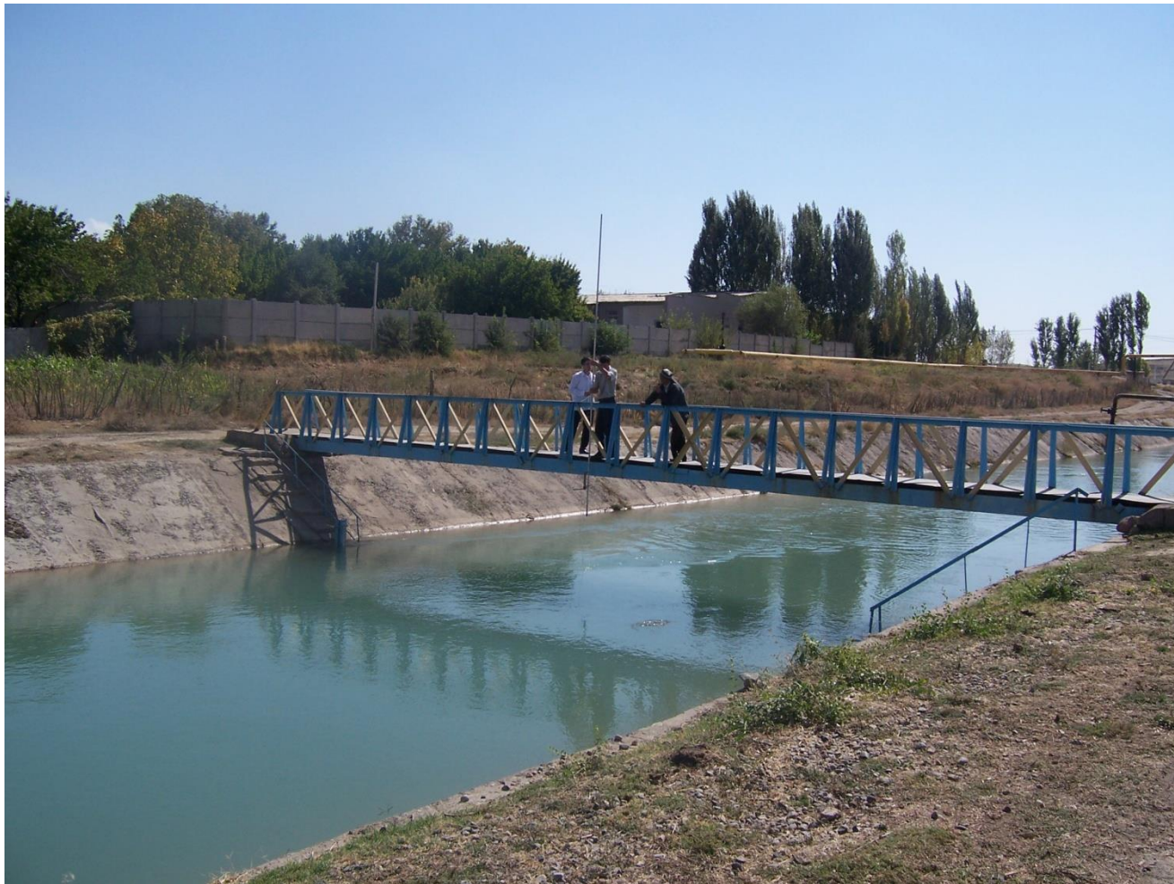
Паркент каналидаги гидропост
