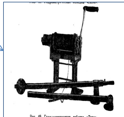
Рис. 40. Гидрометрическая лебёдка «Нева».
