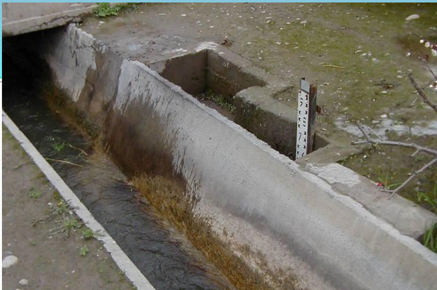
Тинчлантириш қудуқли параболик нов
